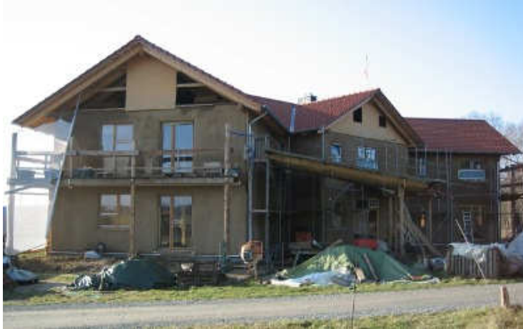
Abbildung A.10: Wohnhaus Windrose in Holzrahmenbauweise (Sieben Linden)
