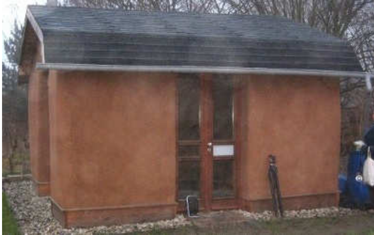
Abbildung A.5: Gartenlaube in lasttragender Bauweise in Berlin-Mariendorf
