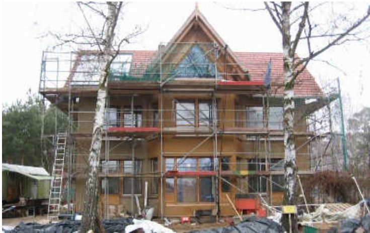
Abbildung A.9: Wohnhaus Villa Communia in Holzrahmenbauweise (Sieben Linden)
