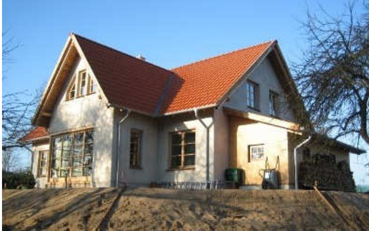
Abbildung A.4: Einfamilienhaus mit TJI-Trägerkonstruktion in Papendorf (Ostvorpommern)
