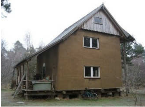
Abbildung A.6: Wohnhaus Villa Strohbund in Holzständerbauweise
